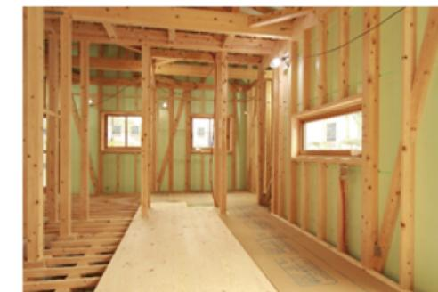
VOC無の構造木材 + 30mm厚フロア板
