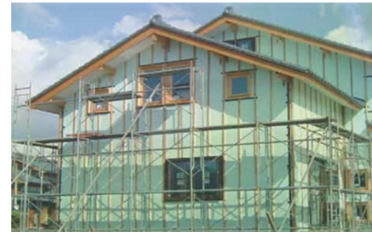
外断熱壁通気工法は、家の内外2重の通気を実現
